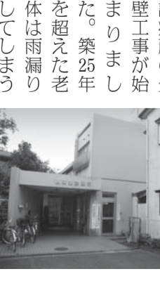
5月初め、西荻窪診療所の外壁工事が始まり、25年を超えた老体は雨漏りしてしまふような状態だったので、満を持しての工事です。
