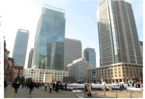
旧東京中央郵便局敷地に 建つJPTタワー
